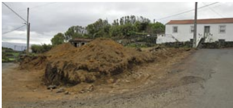
ALARGAMENTO DO CAMINHO DO MIRADOURO, FREGUESIA DA PIEDADE: OBRA INICIADA.
