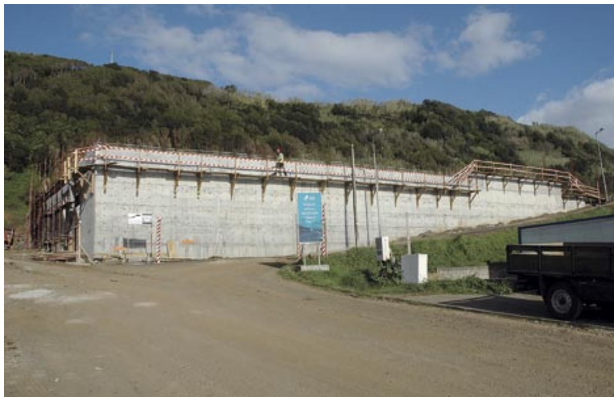
CONSTRUÇÃO DO NOVO CAMPO DE JOGOS MUNICIPAL, FREGUESIA DAS LAJES: FINALIZAÇÃO DA OBRA DE CONSTRUÇÃO CIVIL PREVISTA PARA A SEGUNDA QUINZENA DE DEZEMBRO, A QUE SE SEGUEM CERCA DE TRÊS MESES DE ACABAMENTOS E INSTALAÇÃO DE EQUIPAMENTOS.
