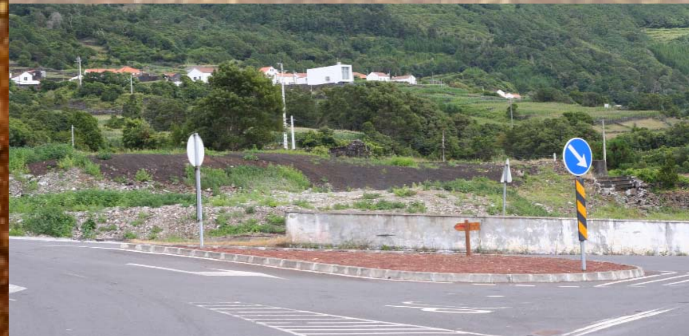
Aquisição da antiga fábrica da Lactopico para demolição e limpeza do espaço, pelo valor de 120.000 euros
