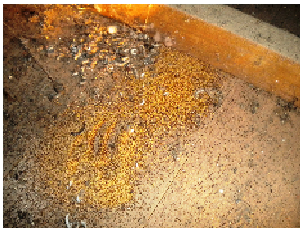
Figura 3-9: Produção orgânica de térmita de madeira seca em falsa na localidade de Santa Cruz das Ribeiras – indício inequívoco da presença da uma espécie de térmita de madeira seca.
